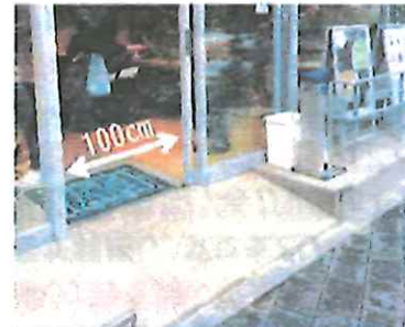
● 改修による自動式引き戸の設置、出入口前後の高低差の解消
